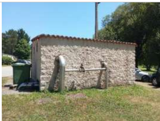
Foto 16. Detalle caseta bombeo
