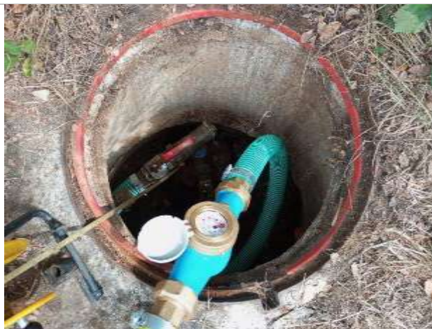
Foto 15. Ensayo hidráulico en POZO_G_1
