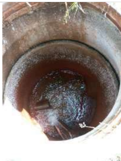
Foto 19. Detalle arqueta colectora del manantial de Bidueira.
