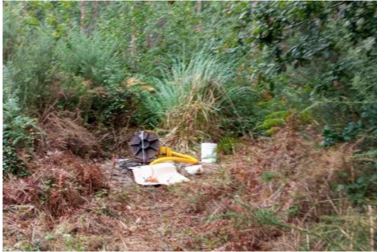
Imagen 3. Arqueta abierta POZO_A_G.
