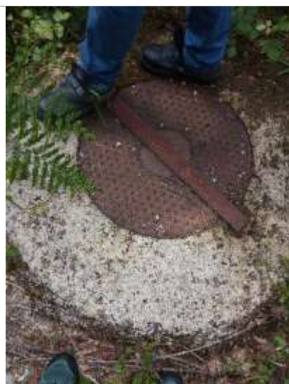
Foto 23. Detalle tapa soldada previo a su apertura del Pozo_A_G.
